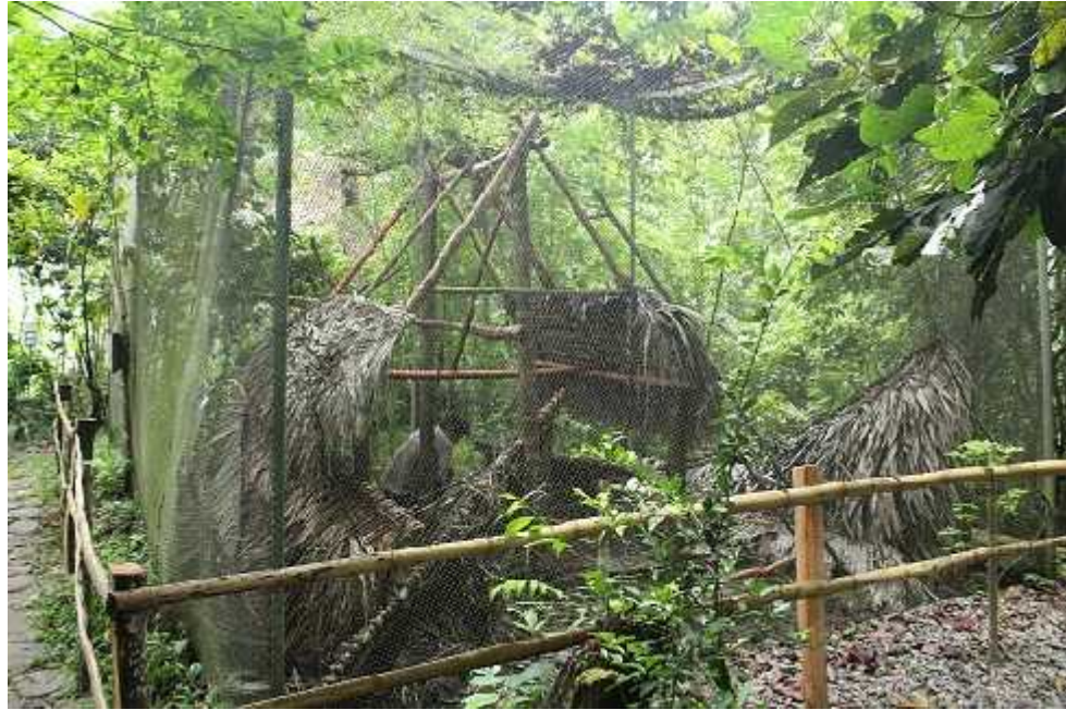
Refacción del recinto del Paujil ( Mitu tuberosum ). Se ha implementado barandas de protección (como en otros recintos).
